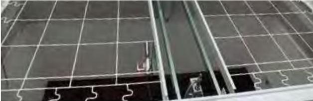
Das Ab- und Durchsturzsischerungssystem EAD LK kann bei allen Kingspan ESSMANN Aufsetzkränzen bereits werkseitig oder als Nachrüstung eingesetzt werden. Mit dem Kingspan ESSMANN Sanierungsaufsetzkranz kann die EAD LK auch für Aufsetzkränze anderer Fabrikate verwendet werden. Durch das innovative Falldämpfungssystem (IFS) wird die Aufprallenergie hervorragend absorbiert und die Unterkonstruktion weniger belastet.
