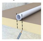
■ Falls Leitungen an der Decke vorhanden sind, die Therma<sup>TM</sup> TR27 Flachdachplatte ansetzen und die Leitungen auf der Platte anzeichnen.
